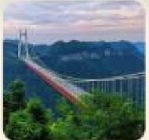
สะพานอ้ายจ้าย
